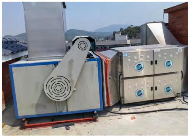
静电光解复合式油烟净化设备
