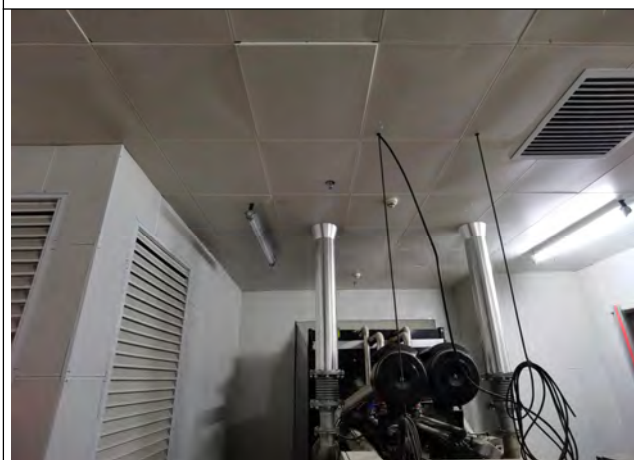
发电机房隔音降噪
