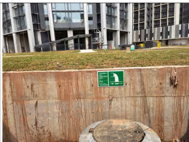
水-01 废水排放口（远）
