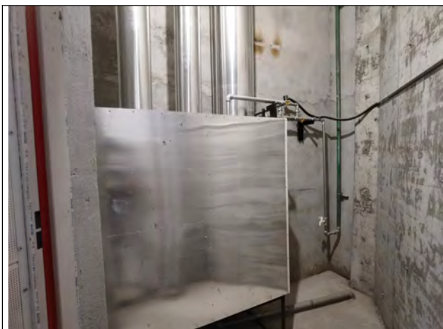
发电机房水喷淋装置
