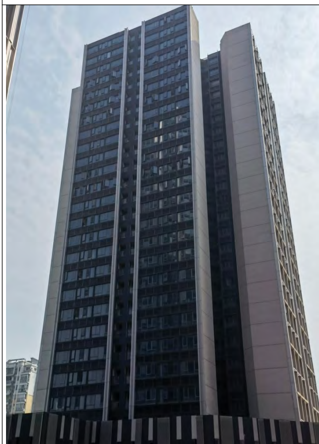
项目已建成住宅楼
