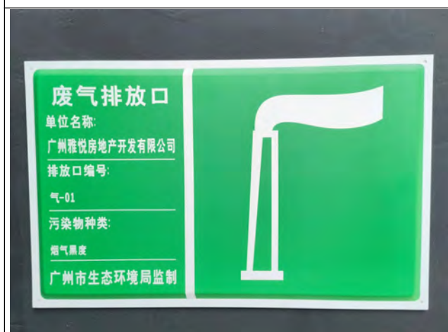
气-01 发电机尾气排放口（近）
