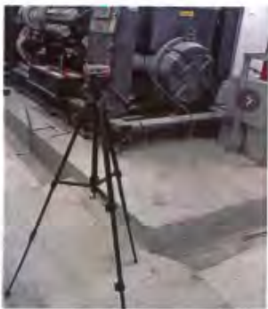
发电机旁 1 米处 N5
