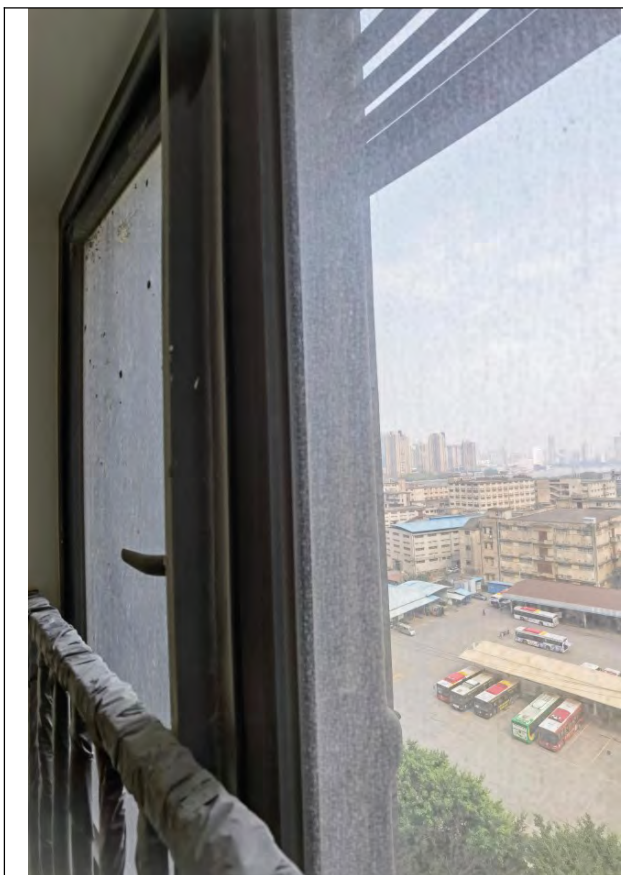
住宅面向道路及停车场已安装双层中空玻璃
