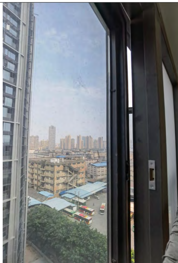
住宅面向道路及停车场已安装双层中空玻璃
