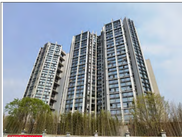
项目已建成住宅楼
