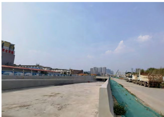
西面在建如意坊放射线系统工程（尚未通车）
