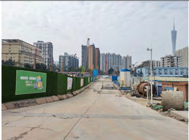
现场道路-工地
