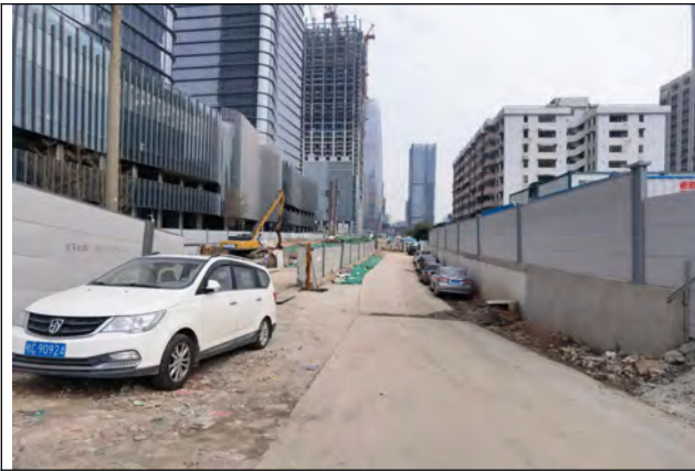
现场道路-工地
