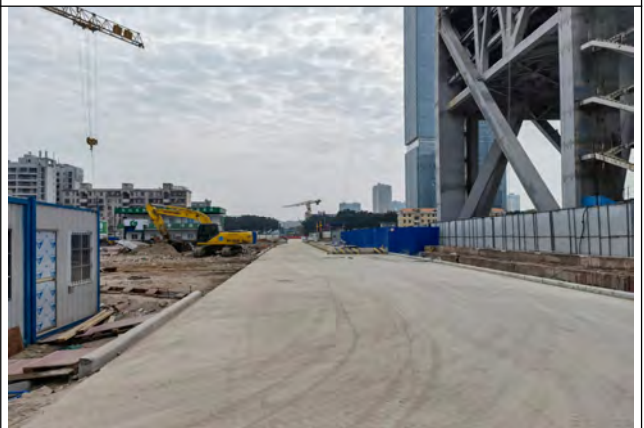
现场道路-工地
