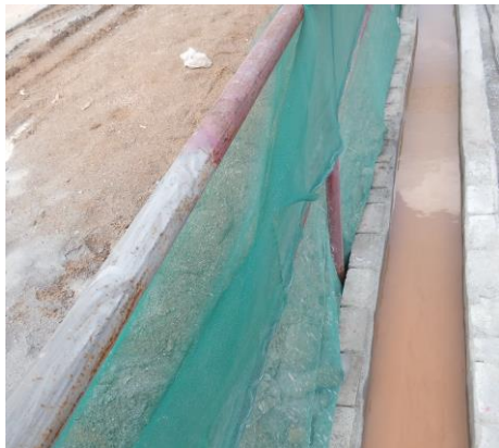
基坑顶部截水沟
