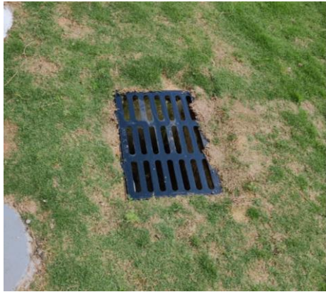
幼儿园雨水排水口
