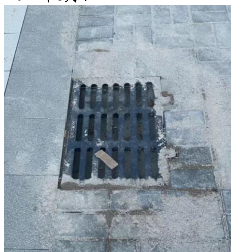
自编1#、3#楼区域雨水排水口
