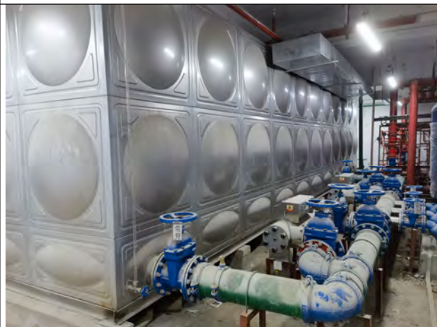
泵房设备隔声、减振降噪
