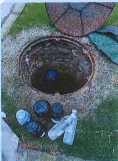
W1 污水站进水口
