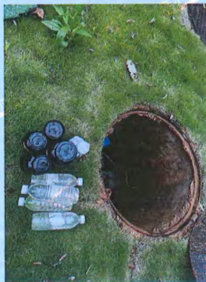
W2 污水站排水口
