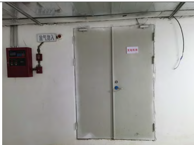
发电机房隔声门
