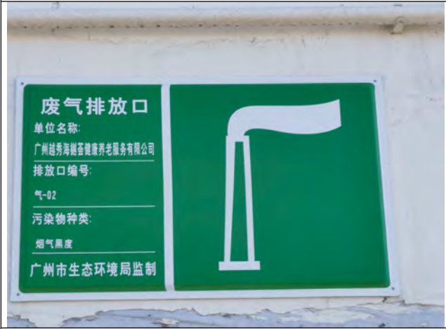
气-02 发电机尾气排放口（近）
