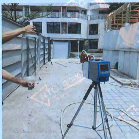
污水处理站边界无组织下风向监控点 4#
