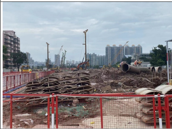
现状工地（规划四路区域，原空地）
