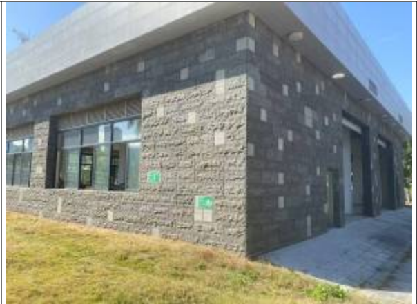
气-09 垃圾站臭气排放口（远）
