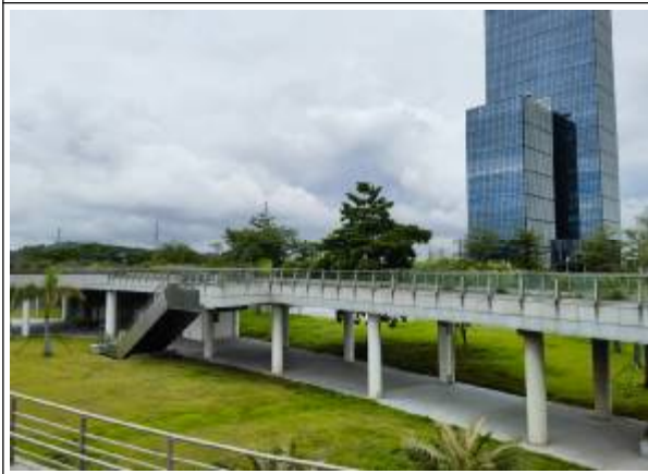
项目地上绿化、通道
