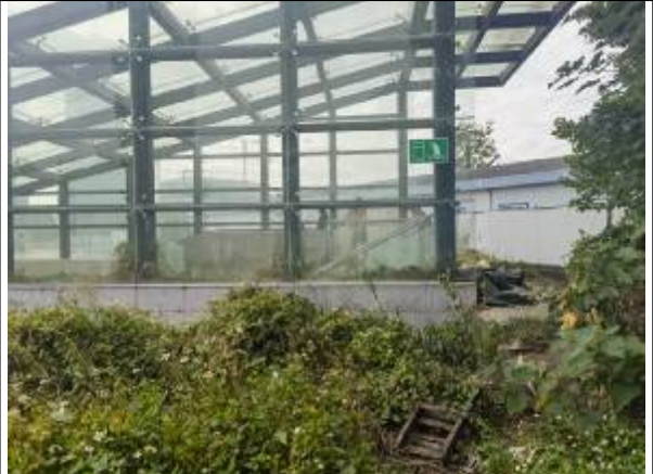
水-01 废水排放口（远）
