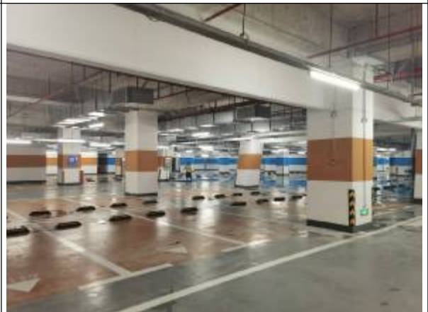
项目已建地下停车场
