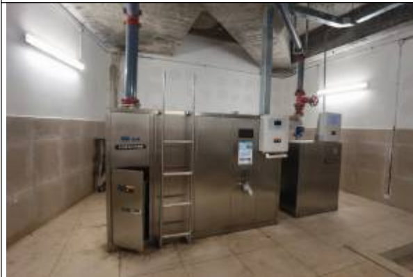
隔油隔渣设施（多功能油水处理器+污水提升装置）
