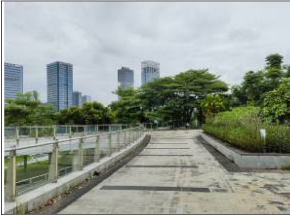
项目地上绿化、通道
