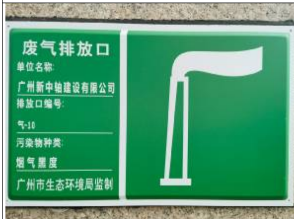
气-10 1#发电机尾气排放口（近）
